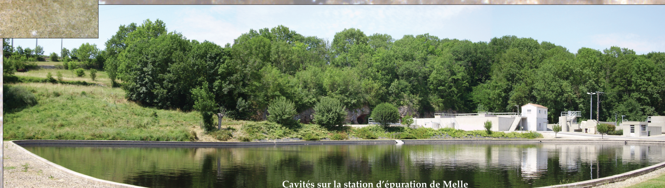
Cavités sur la station d'épuration de Melle
