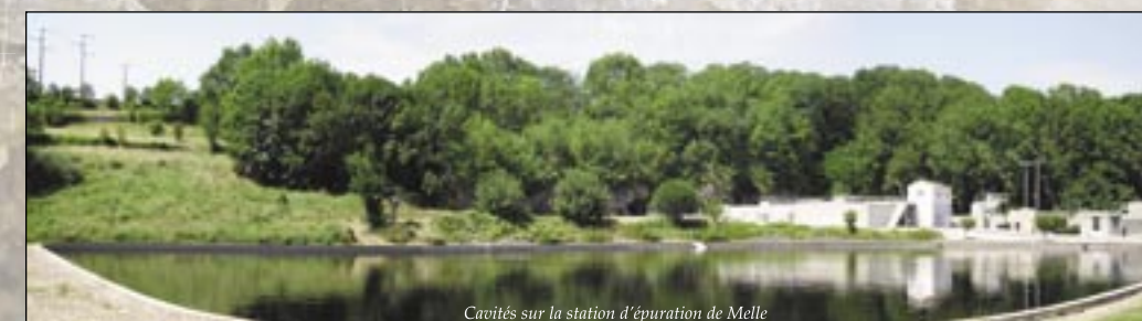
Cavités sur la station d'épuration de Melle
